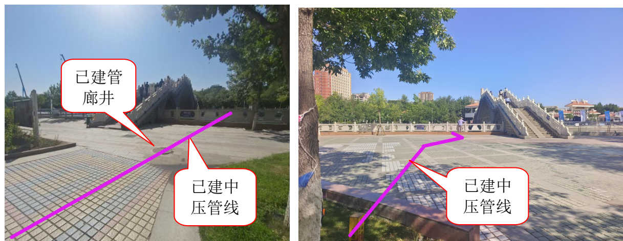
图4.5.1.1.2-2、滨河小区来气燃气管线更换项目（穿城河）现状图
