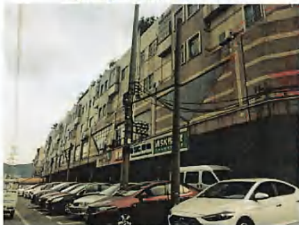
7栋四排（临同兴路）外观
