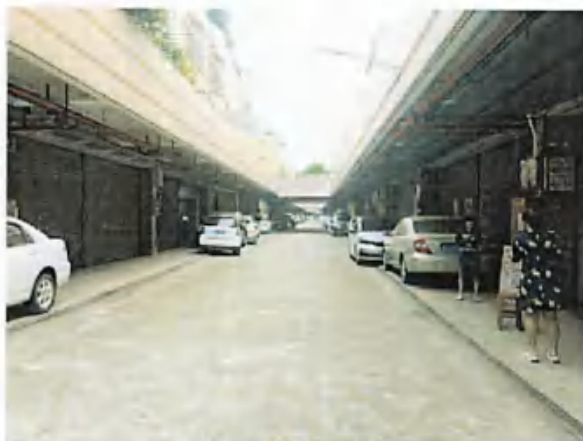
A区二层商铺现状-1
