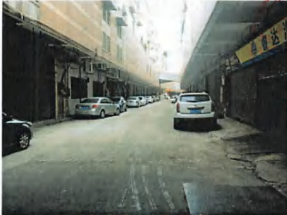
2排、3排首层现状-1
