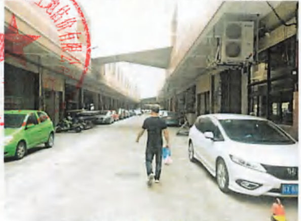
2排、3排首层现状-2
