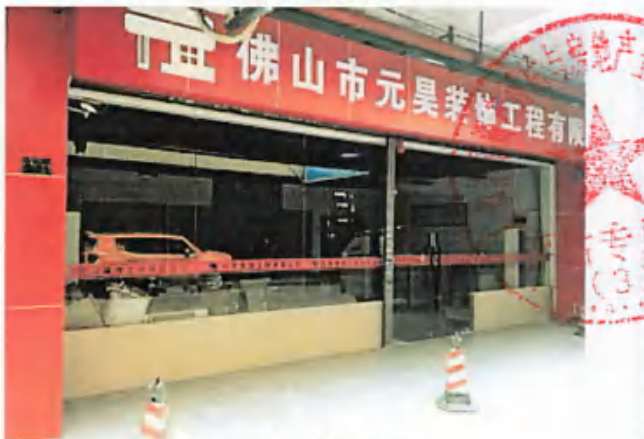
A区二层商铺现状-3
