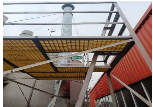
3#厂房：布袋除尘器
