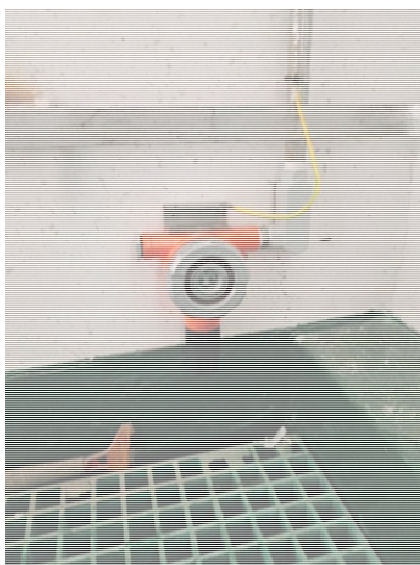
危废间地沟、漏液监测系统及门槛
