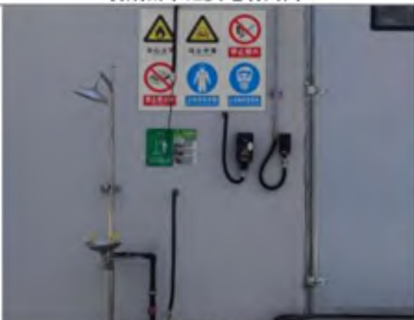
危废库喷淋设施及电控开关
