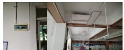
注: 照明灯具及电气设备、线路的高温部位, 当靠近非A级装修材料或构件时, 应采取隔热、散热等防火保护措施, 与窗帘、帷幕、幕布、软包等装修材料的距离不应小于500mm; 所有灯具采用不低于B1级材料。
