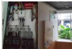
拆除原有总电柜一个，尺寸750mm宽X1200mm高，按系统图IAP定制总电柜，墙面拆除及修复
