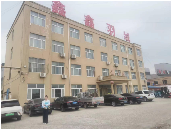
工程师现场踏勘照片
