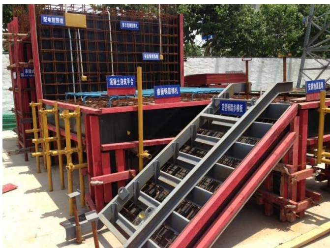
结构施工样板（包括钢筋绑扎、线盒预埋、楼梯踏步等）线盒预埋样板（线盒兼做灰饼）
