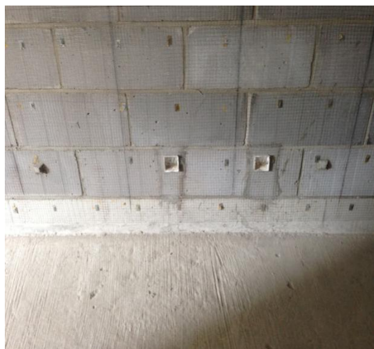
结构施工样板（包括钢筋绑扎、线盒预埋、楼梯踏步等）线盒预埋样板（线盒兼做灰饼）
