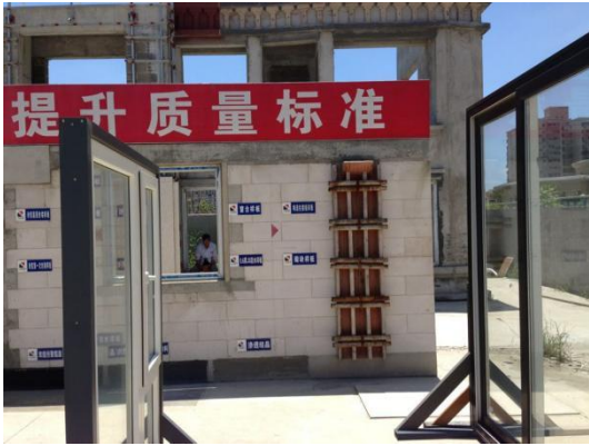
砌体、二次结构，门窗安装及收口样板厨卫间降板样板
