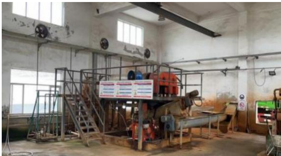
图 2.4.7-4 生化污泥离心脱水机
