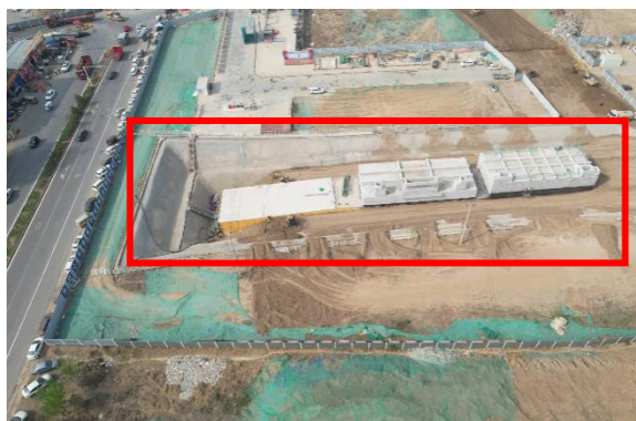
E4 综合管廊，2023.04，镜像西
