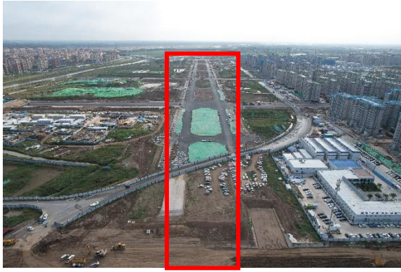
E3 路综合管廊，2023.10，镜像东
