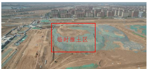
3#临时堆土场（2023.8，镜像：北）
