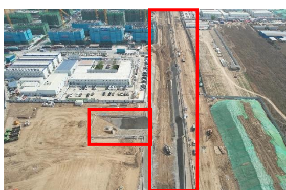
N7 路综合管廊，2023.04，镜像东
