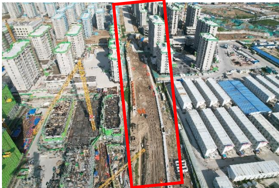
E10 路组合排管，2023.09，镜像西
