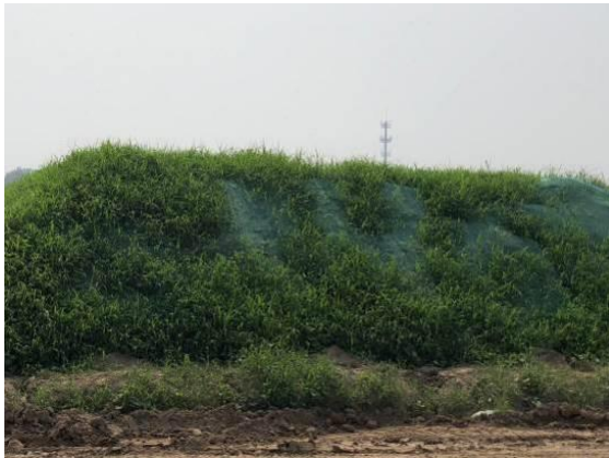
临时堆土区撒播草籽，2023.09，镜像东
