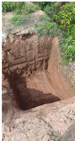
临时堆土区沉沙池，2023.09，镜像东
