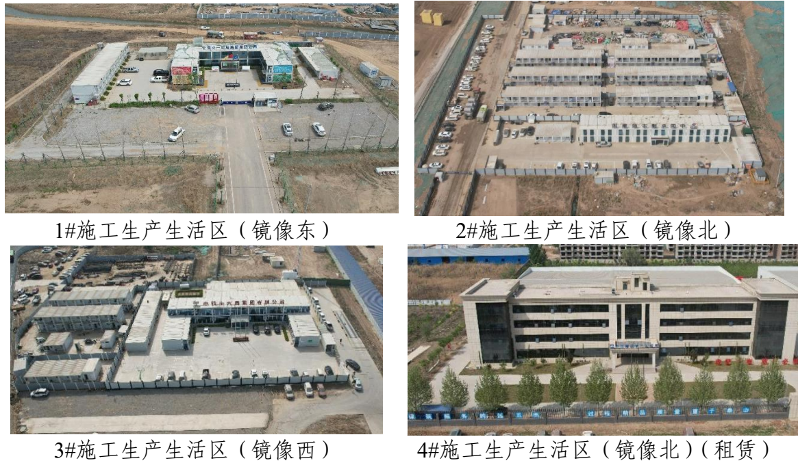
图 2.1-16 施工生产生活区现状（拍摄时间：2024.3）
