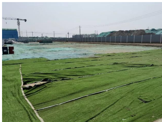
施工伴行路和基坑苫盖，2023.09，镜像北
