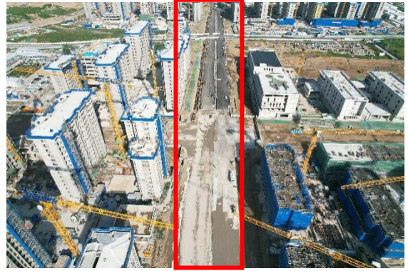
E4 综合管廊，2023.09，镜像西
