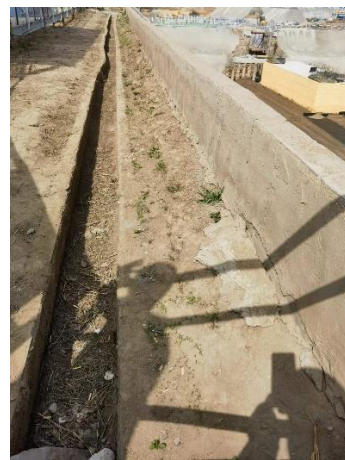
管廊挡水墙、截水沟，2023.09，镜像东
