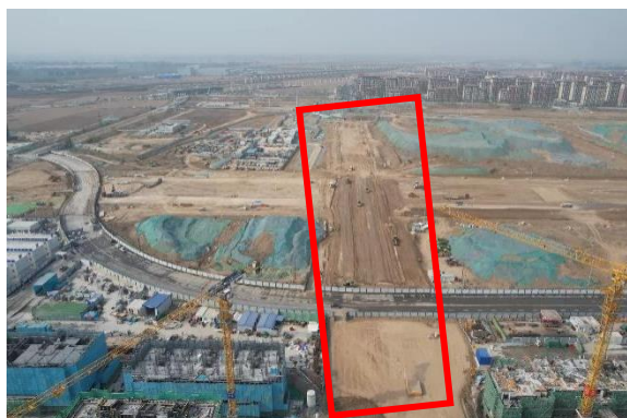
E4 综合管廊，2023.04，镜像西
