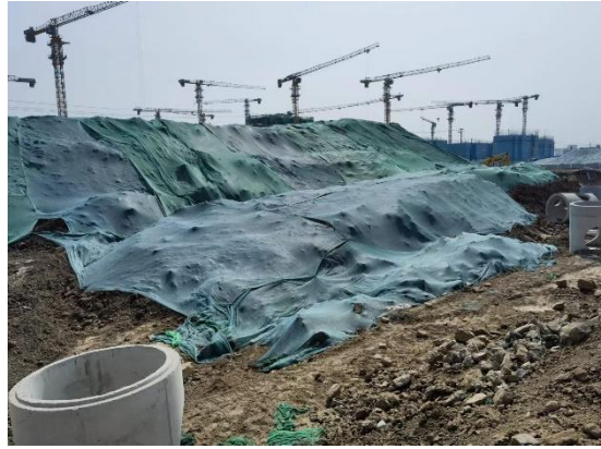
临时堆土区苫盖，2023.09，镜像南
