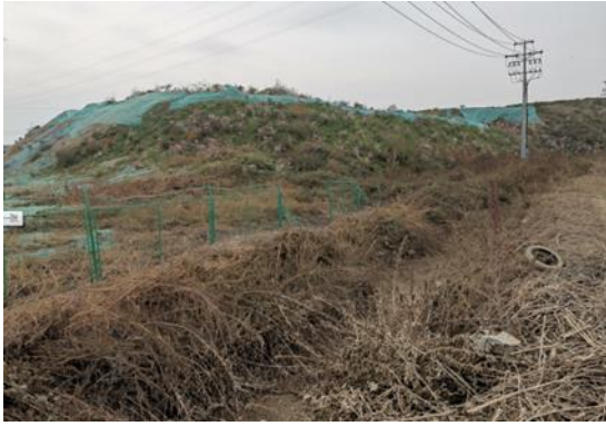
临时堆土区排水沟，2023.09，镜像北
