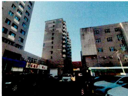
所在建筑及周边状况
