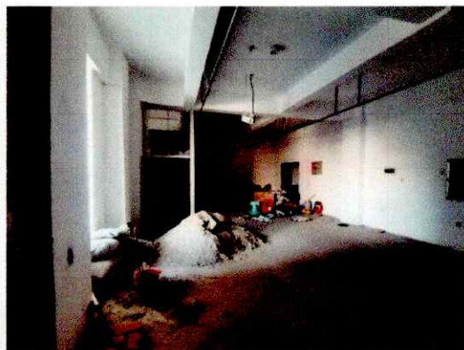
估价对象内部
