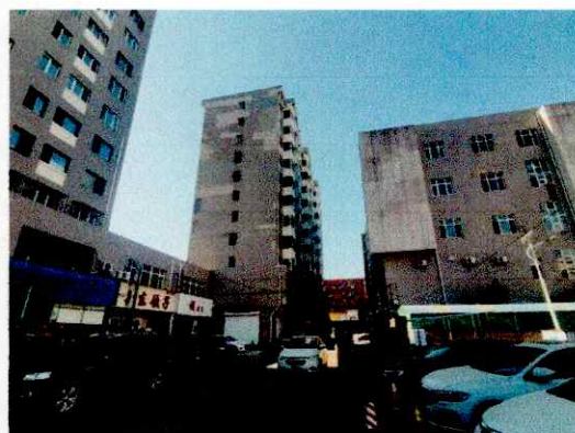
所在建筑及周边状况
