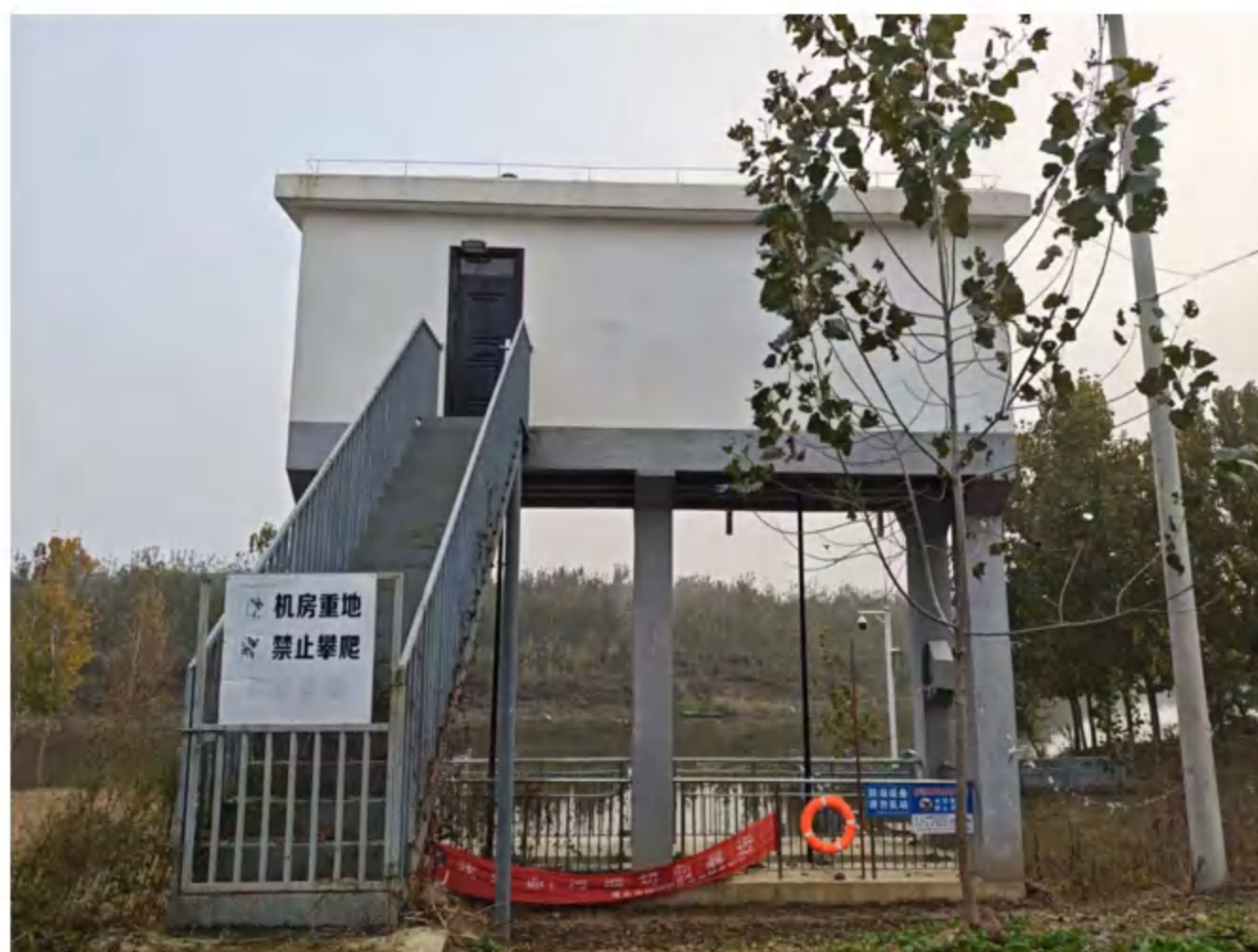
徐洼沟防洪闸
