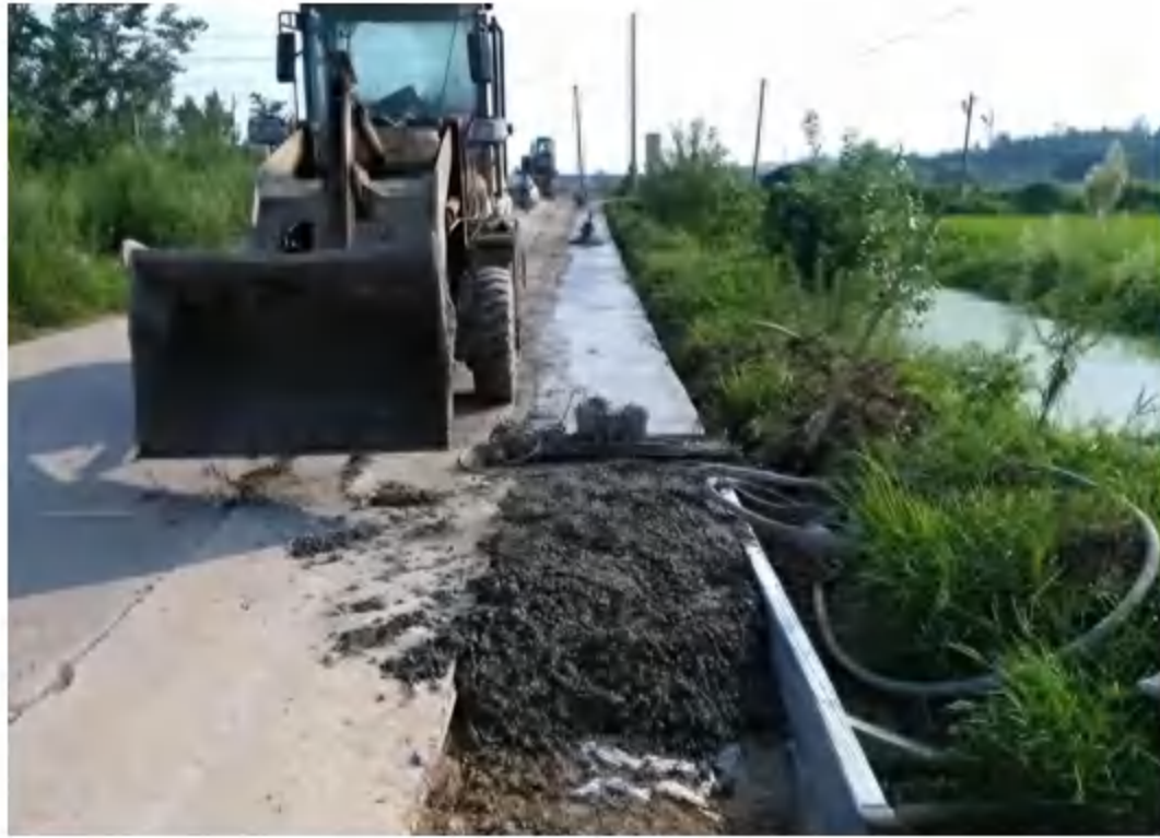
水泥混凝土路面扩宽示意
