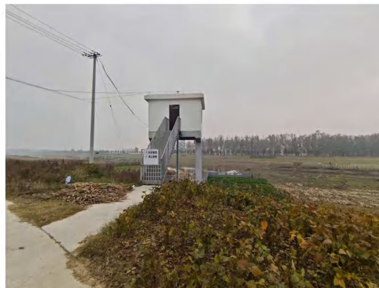
新祁沟防洪闸
