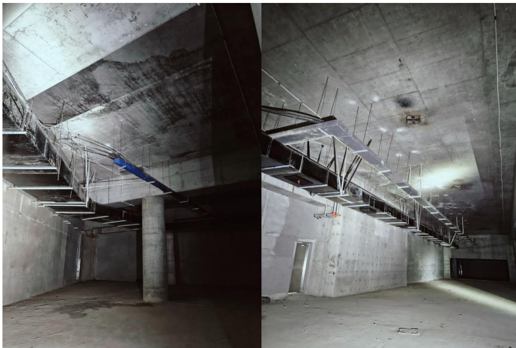
图2.2-1 换乘通道通风空调现状管道图
