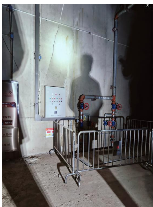
图 4.1-2 现场水泵配电箱及防火卷帘配电箱已安装到位
