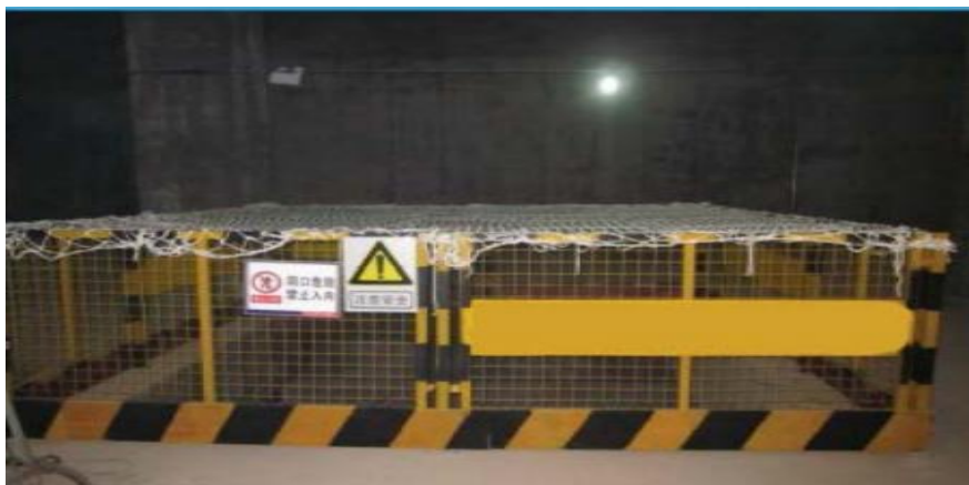
预留洞口防护（长边尺寸大于 1.5m）
