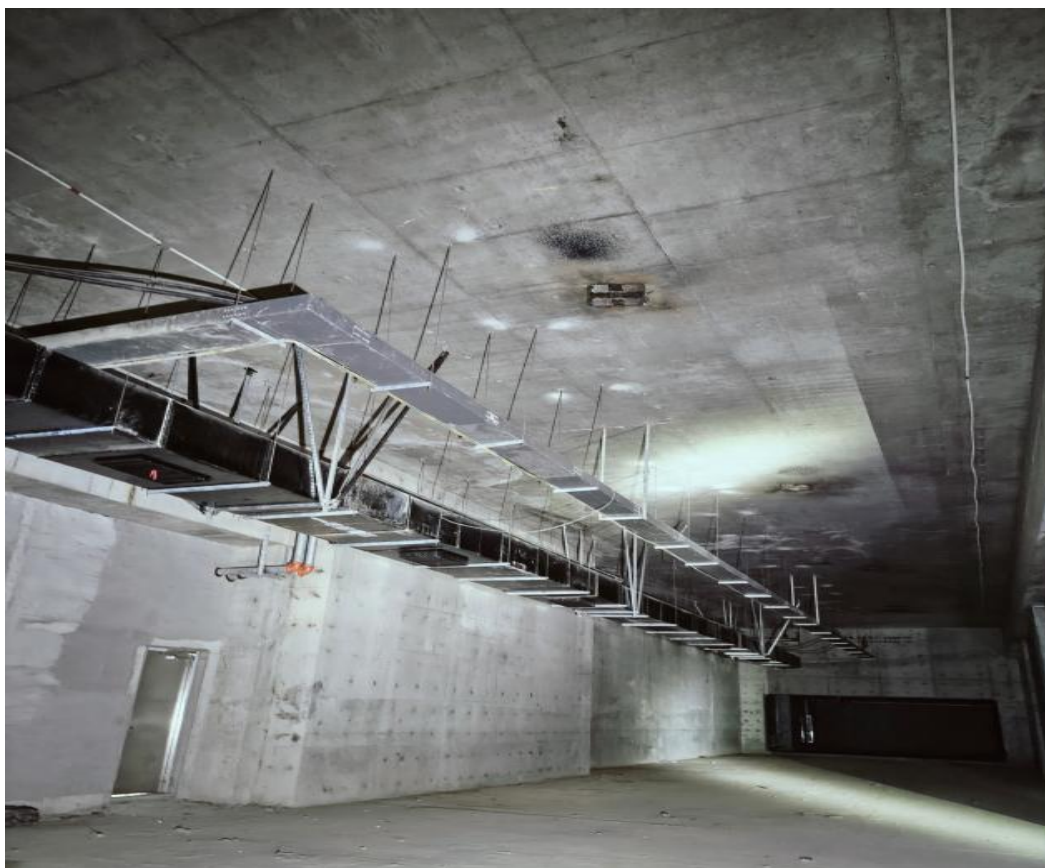
图 4.1-3 现场装修现状
