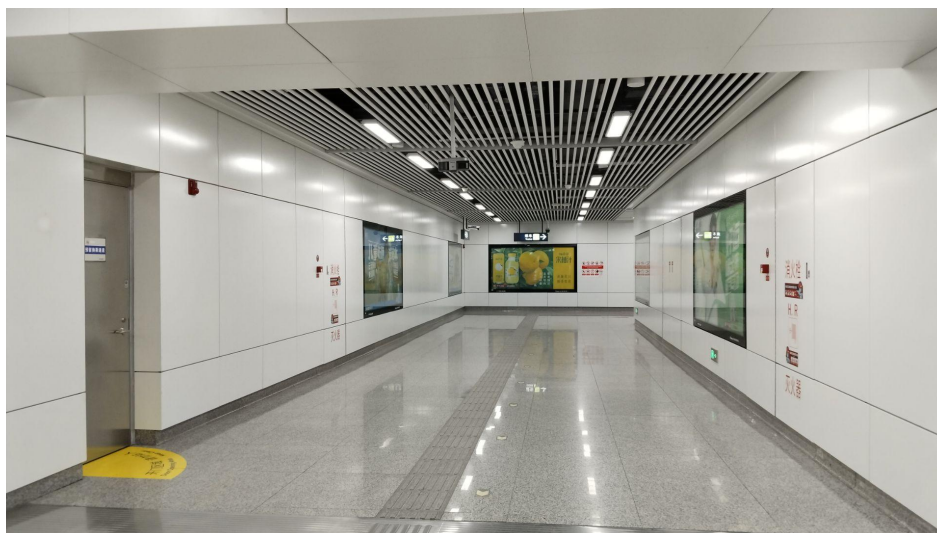
图1.1-3 D出入口通道侧墙2需进行改造
