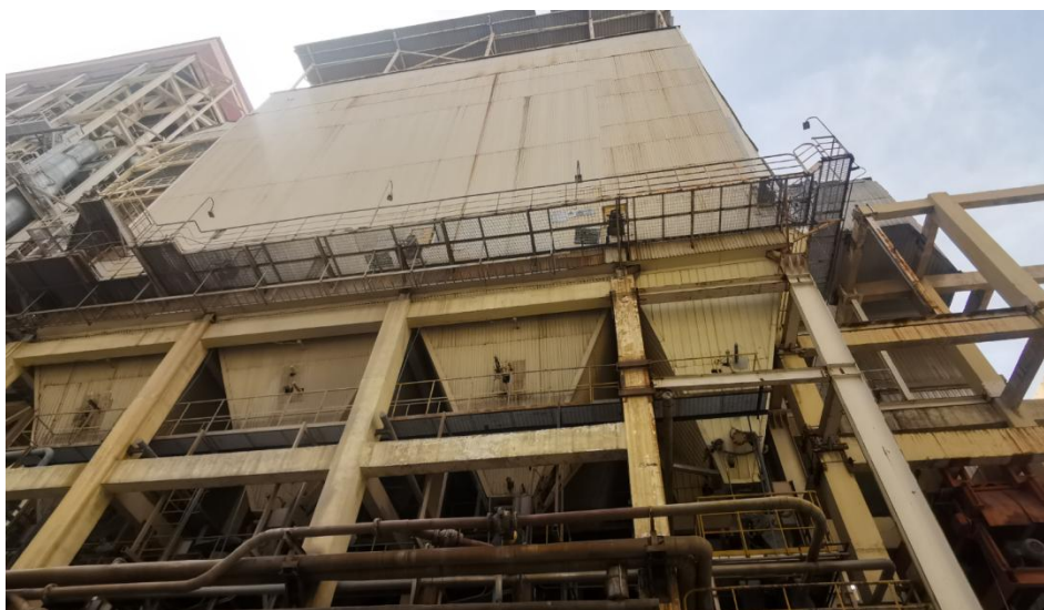
图 1.1-2 #1 机组静电除尘器（除尘器钢柱扩展至与引风机支架齐平）
