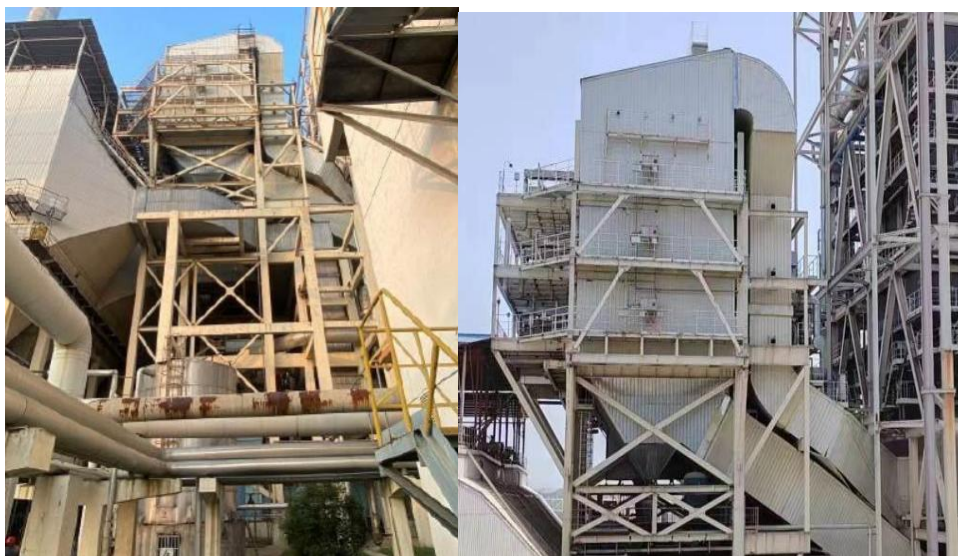
图 1.1-1 现场 SCR 脱硝装置
