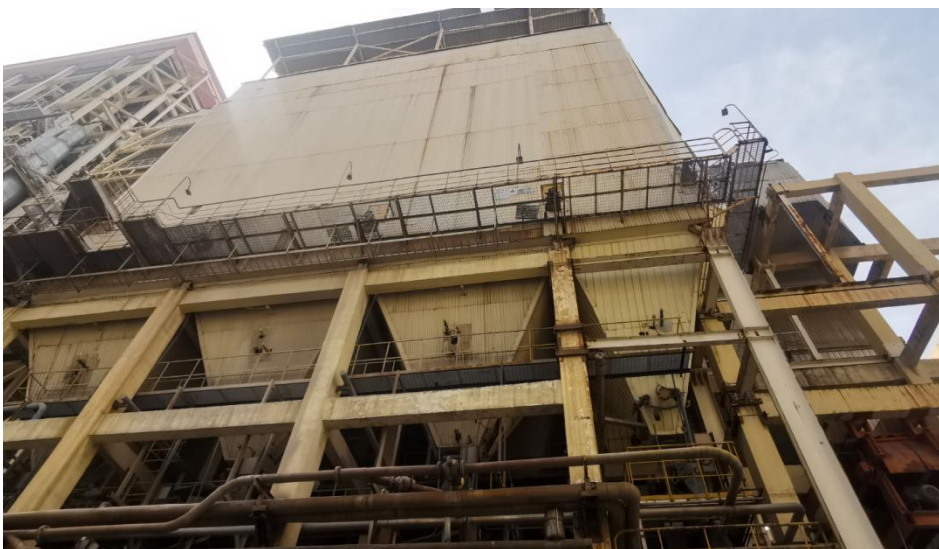
图 4.3-1 #1 机组静电除尘器
