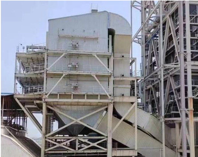
图 4.2-1 SCR 脱硝装置
