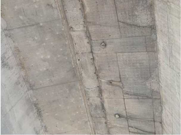
图 9-49 引桥泄水管现状
