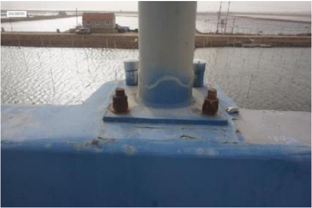
图 9-55 固定螺母保护罩缺失
