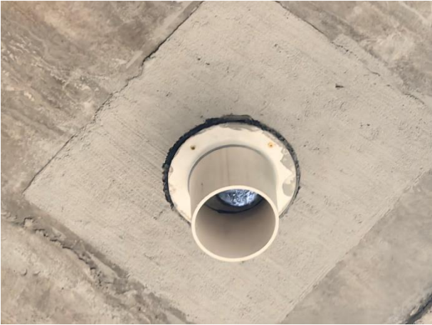
图 9-52 改造后泄水孔示例
