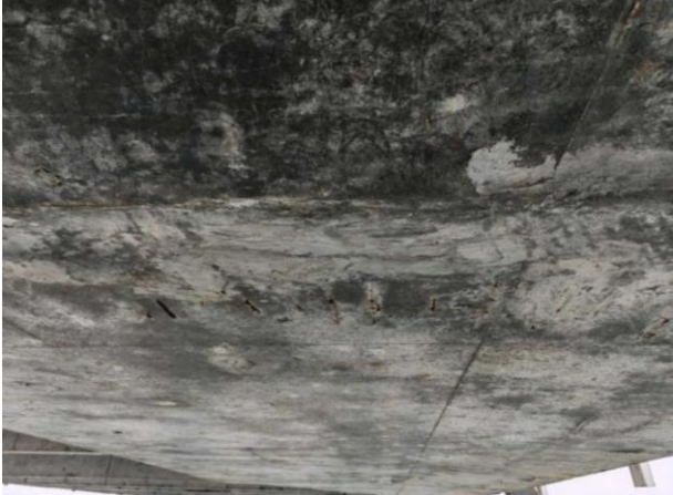
图 9-6 节段梁露筋
