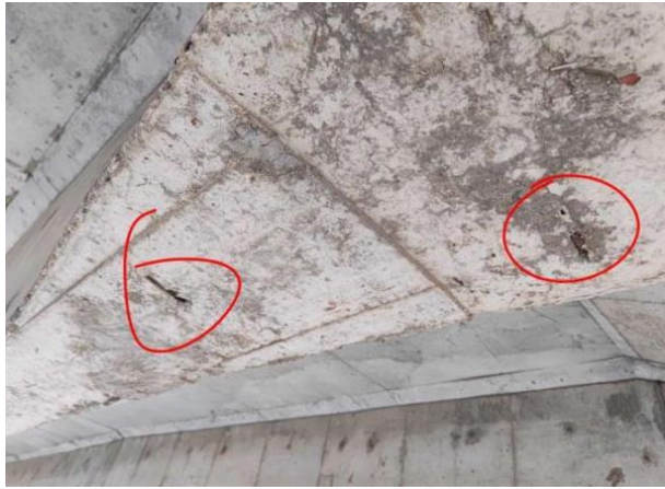
图 9-5 横隔板露筋
