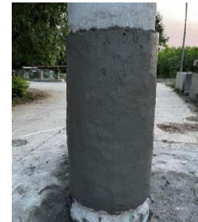
图 9-32 UHPC 材料喷射施工后
