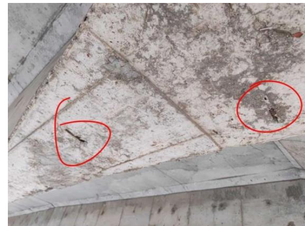
图 9-13 主梁露筋
