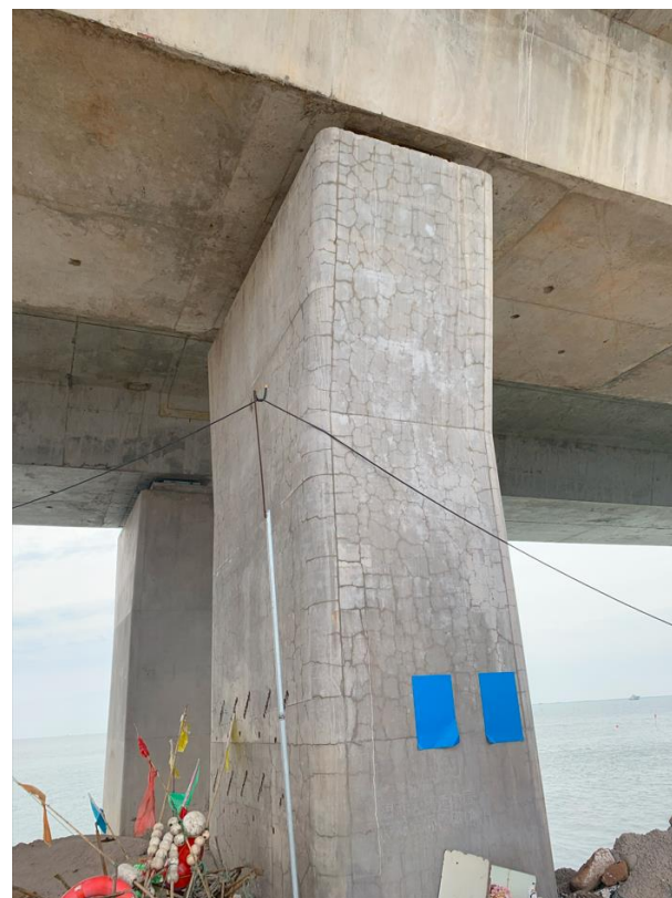
图 9-28 北引桥右幅 39#墩现状
