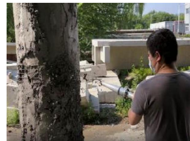
图 9-31 UHPC 材料喷射施工
