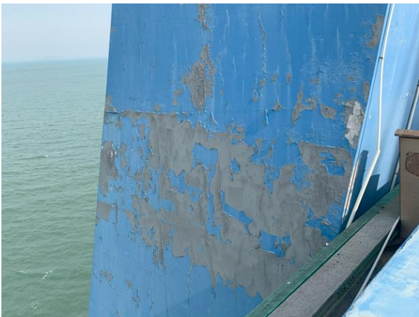
图 9-16 索塔表面保护涂层剥落
