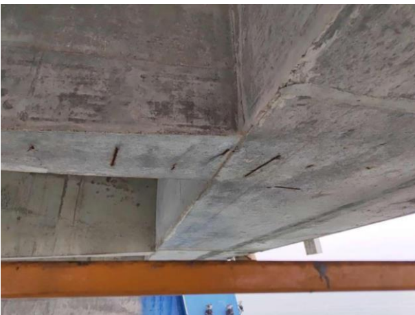
图 9-14 横隔板露筋
