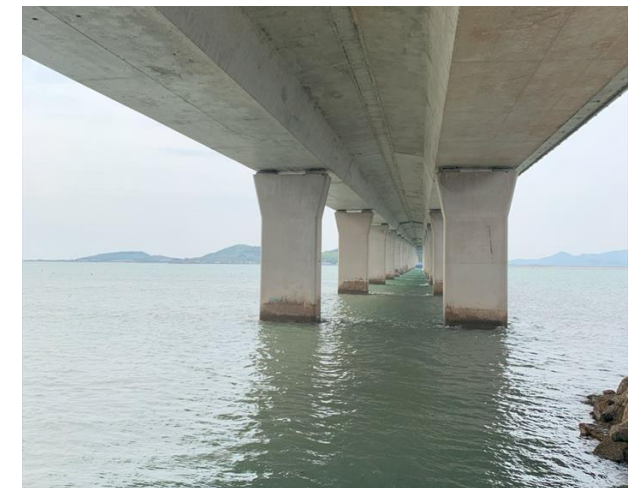
图 9-30 浪溅区引桥墩现状
