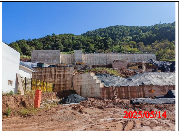
图 3 选厂内建设的挡墙
