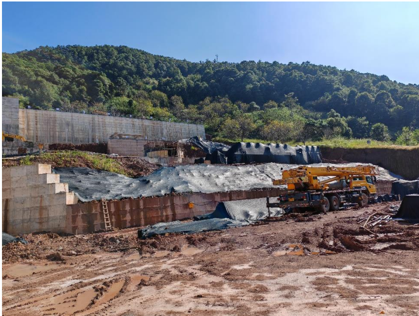
图 3.13.1-1 选厂内建设的挡墙、地表覆盖照片
