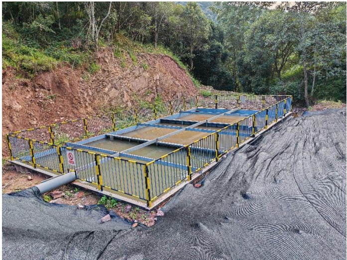
图2.3.12-10 排水隧洞出口涌水三级沉淀池
