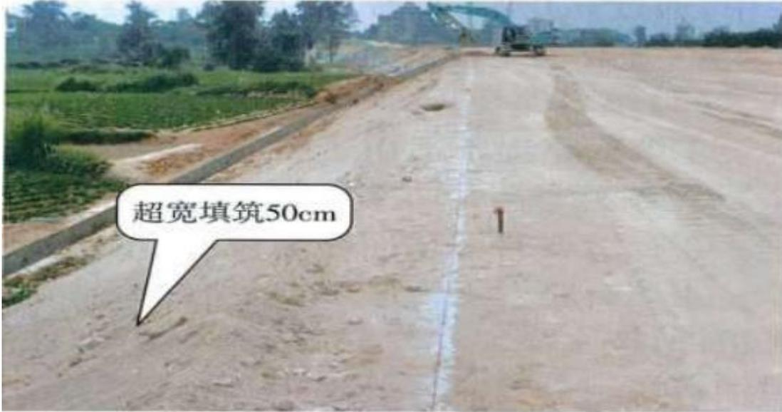
（3）具备条件的填方作业面应推行“四区法”填方作业方式’即将作业面分进料区、整形区、碾压区、检测区等四个作业区。进料区应按“画格上土”的方式有序进料；整形区应认真插竿挂线，采用平地机进行整平，严格控制松铺厚度；碾压区应采用两边向中间碾压的方法施工，达到无漏压，无死角，确保碾压均匀；检测区应认真进行平整度、压实度检测，确保路基表面平整，边线直顺，曲线圆滑，控制好“五度”。
