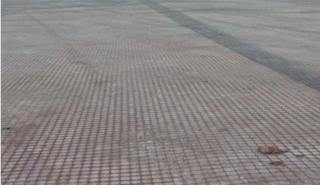
铺设土工格栅的土层表面应平整，表面严禁有碎、块石等坚硬凸出物；在距土工格栅 8cm 以内的路基填料其最大粒径不得大于 6cm；
