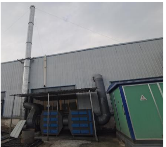
（挤出废气两级活性炭吸附处理装置及 DA002 排气筒）
