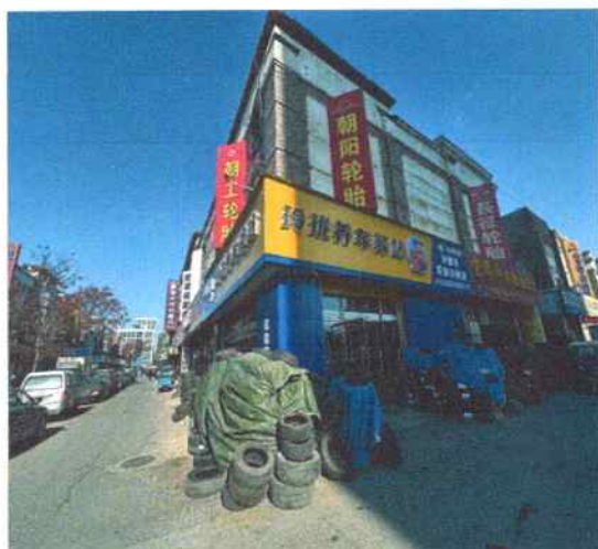
估价对象所在楼外景
