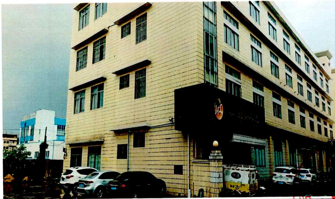
江门市蓬江区建设三路 185 号 12 幢第三层、第四层标的物图片
