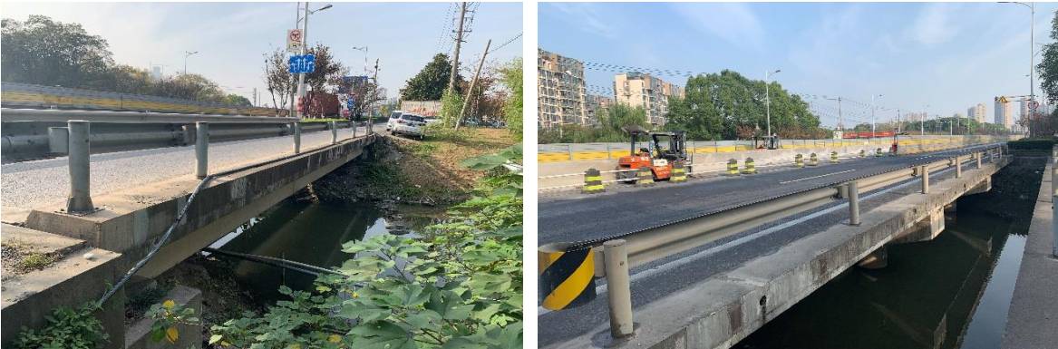
桥梁上部结构
