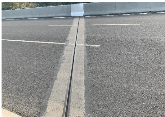
橡胶条破损
