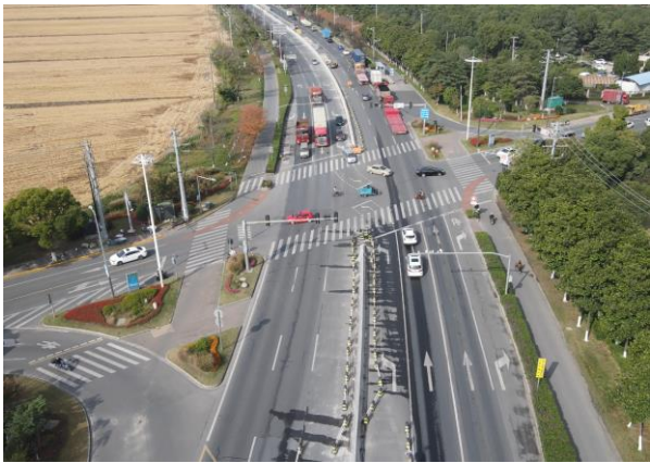
双华路灯控交叉口现状
