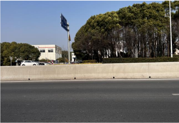
超高段隔离墩泄水孔排水
