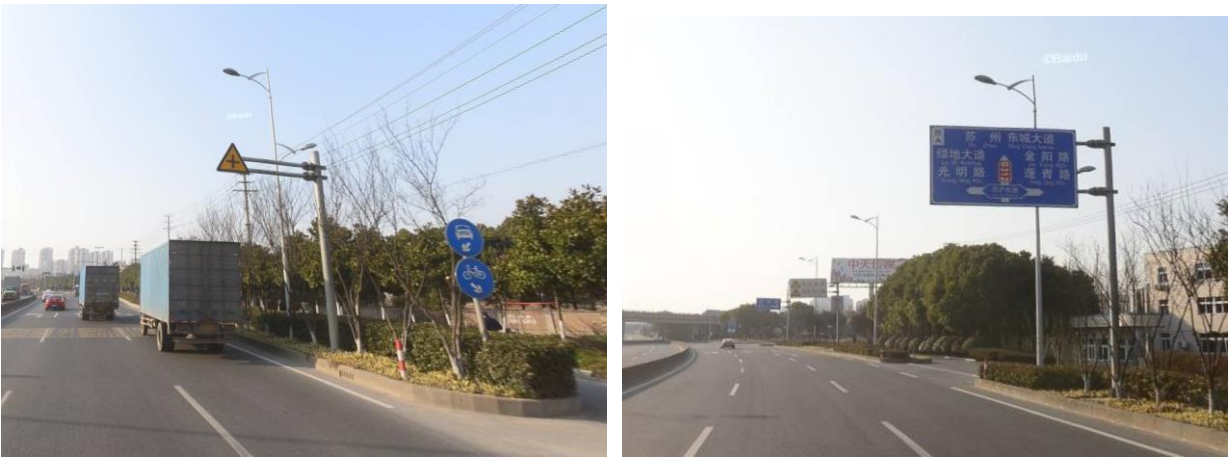
交通安全设施现状
