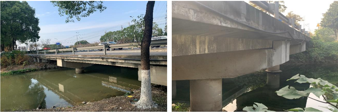
桥梁下部结构
