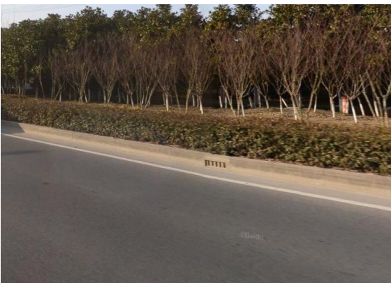
现状侧分带侧向雨水口
