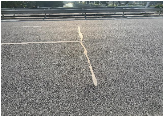
鸡鸣塘桥桥面铺装
