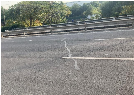
小瓦浦桥桥面铺装
