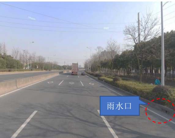
机动车道边缘雨水口
