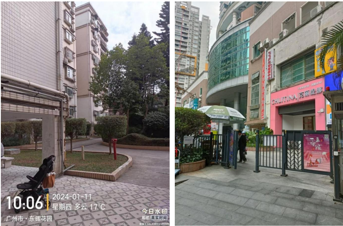
小区外墙立面照片
