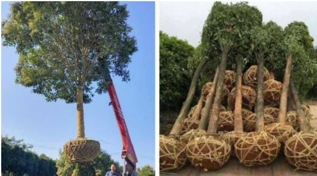
图 8.19.7-9 树木吊运装车示意图
