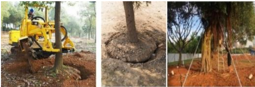
图 8.19.7-7 树体挖掘示意图
