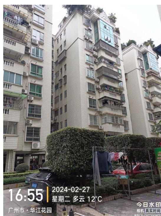
小区外墙立面照片
