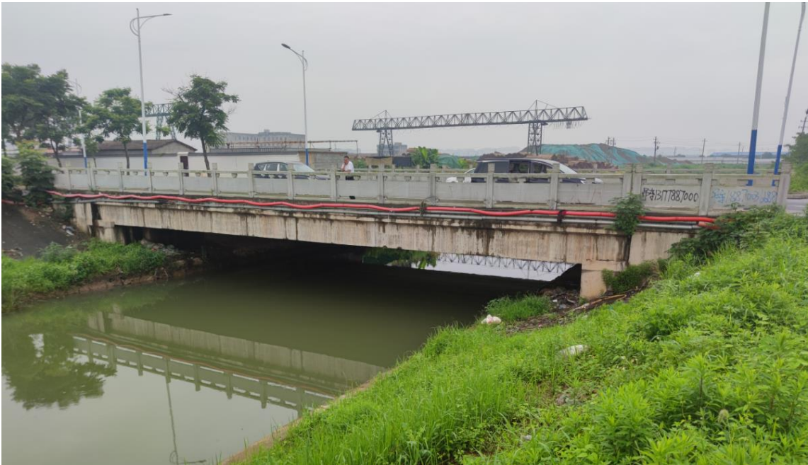
杨家山路桥实景
