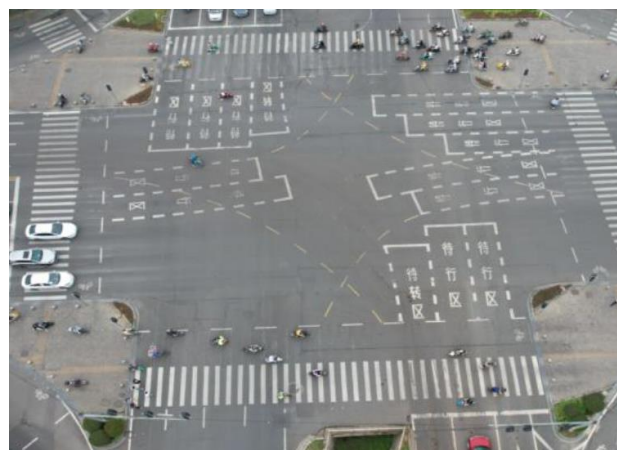
北京东路桥平面俯视
