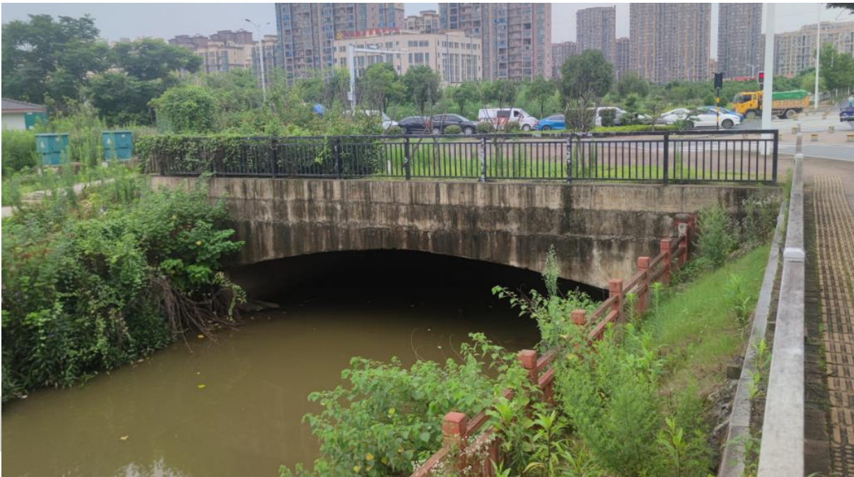
洛阳东路 K5 箱涵桥实景
