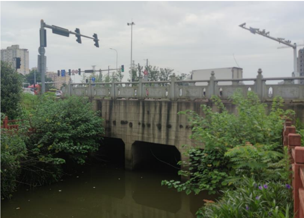
月坊南路箱涵桥实景
