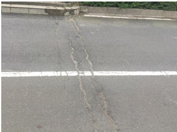
东、西幅桥伸缩缝失效
