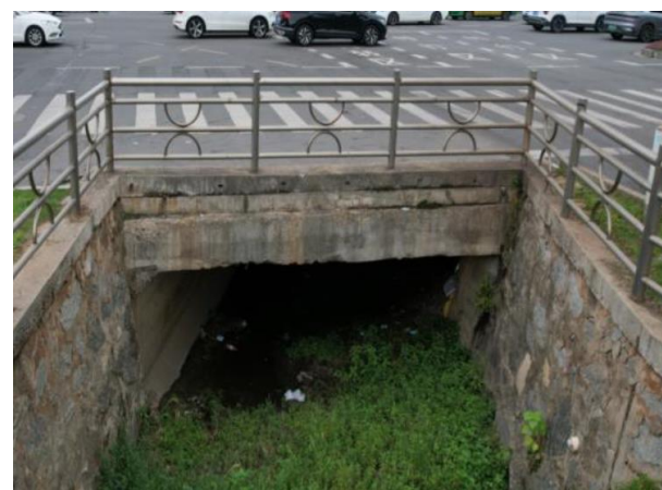
北京东路桥立面正视
