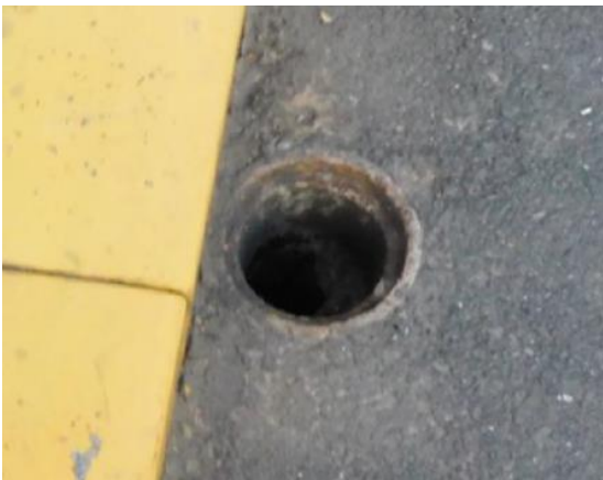
个别泄水孔堵塞、雨水篦子缺失
