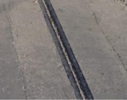
东、西幅桥伸缩缝堵塞卡死
