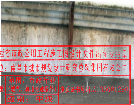
东、西幅桥伸缩缝堵塞卡死
